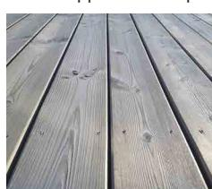
**3–6 MÅNADER EFTER.** Om ytan både fått ta del av solljus såväl som regn har en jämn och silvergrå yta bildats. Underhållet är mycket enkelt, behandla ytan med Wood protection spädd med vatten 1:1. Behandlingen stärker träet ytterligare.
