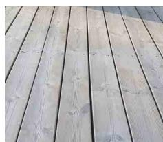
**NACH 4 WOCHEN.** Ein Zeichen für die Wirkung des Siliziums ist, dass dünne Holzfasern ausgefällt werden. Das ist völlig normal. Diese können einfach weggebürstet werden. Die Faserfreisetzung ist bei verschiedenen Holzarten und Qualitäten unterschiedlich.
