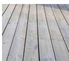
**4 UKER ETTER.** Et tegn på at silisiumet har begynt å virke, er at treet feller tynne trefibre. Det er helt normalt, og disse kan også børstes bort. Forskjellige treslag og -kvaliteter slipper fiber på forskjellige måter.
