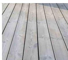
**4 Viikon Kuluttua.** Ohuiden puukuitujen irtoaminen on merkki siitä, että pii alkaa vaikuttaa. Se on täysin normaalja ja myös nämä voidaan harjata pois. Kuitujen irtoaminen riippuu puulajista ja laadusta.
