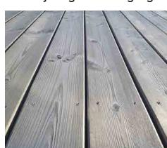
**3–6 MÅNEDER ETTER.** Hvis overflaten har blitt utsatt for både sollys og regn, har det dannet seg en jevn og sølvgrå overflate. Vedlikeholdet er veldig enkelt. Overflaten behandles med Wood Protection fortynnet med vann 1: 1. Behandlingen styrker treet ytterligere.
