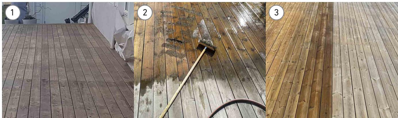
**NACH 1 WOCHE.** Die Oberfläche kann sich stark verfärbten und auch einige „Kalkflecken“ aufweisen, die durch Regen und Sonne allmählich verschwinden. Dies kann durch Bürsten und Wasser reduziert werden.
