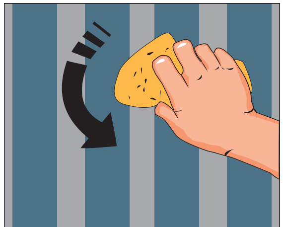
Limsøl på forsiden av tapeten må fjernes umiddelbart og forsiktig med en myk, våt tapetsvamp.
